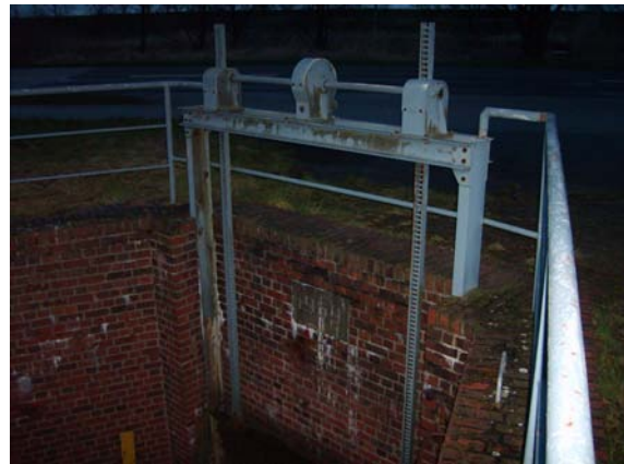
Schleuse (Siel) östlich von Borstel
